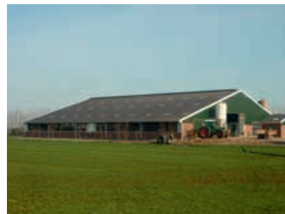
Bouwt u nieuwe gebouwen op een minimale afstand van de erfgrans (insteek sloot). Op de erfrand is dan ruimte voor inpassing met inheemse beplanting.
