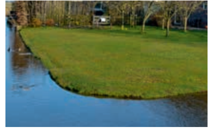
De oevers van het veenweide erf zijn begroeid met gras tot aan de slootkant. Het flauwer maken van een steile oever heeft de voorkeur boven het aanleggen van een beschoeiing. Houd eventuele beschoeiing net onder of op de waterlijn.
