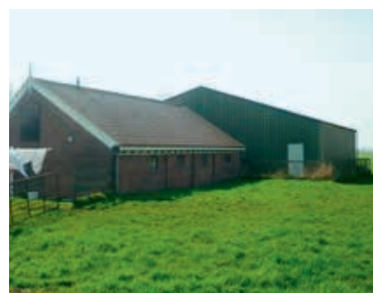
Contrast tussen streekeigen bouwstijl en een uniform gebouw dat tegenwoordig overal in Nederland wordt gebouwd. Door te kiezen voor een streekeigen bouwstijl draagt u bij aan de identiteit van uw streek.
