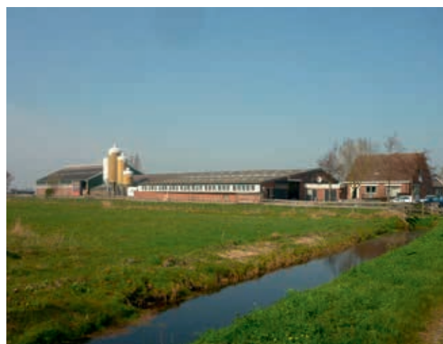
Zonder streekeigen beplanting staat de stal los van het omringende landschap. Door het planten van een bomenrij op de erfranden wordt het erf met al de bebouwing weer één met het landschap.
