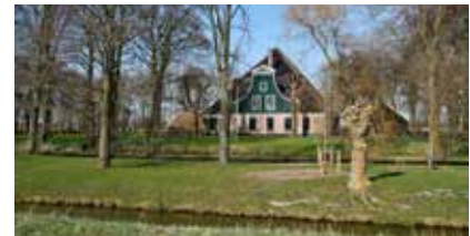
Een Noord-Hollandse normaalstolp met een houten topgevel.
