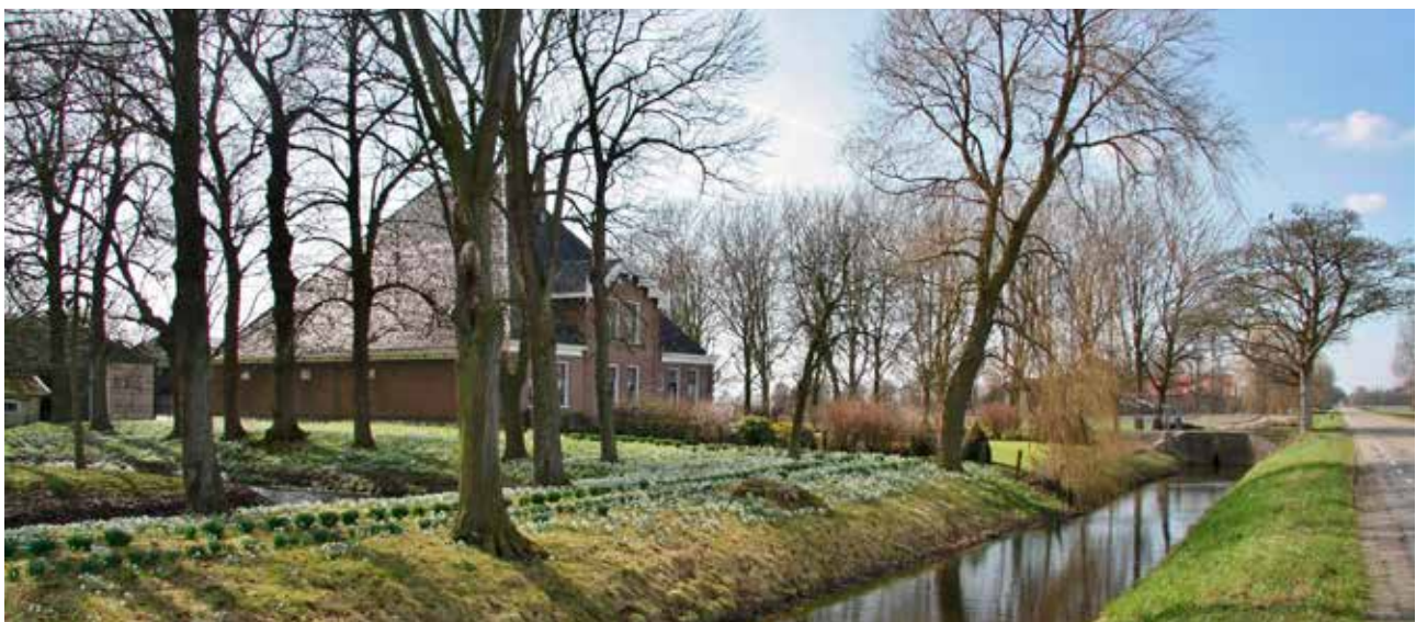
Een Noord-Hollandse normaalstolp met stenen topgevel.
