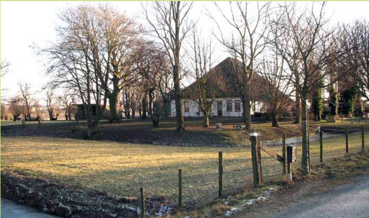
Door regelmatig onderhoud te plegen, behoudt u de streekeigen uitstraling van de bebouwing en beplanting op uw erf.
