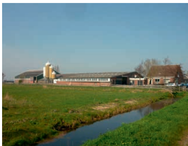
Zonder streekeigen beplanting staat de stal los van het omringende landschap. Door het planten van een bomenrij op de erfanden wordt het erf met al de bebouwing weer één met het landschap.
