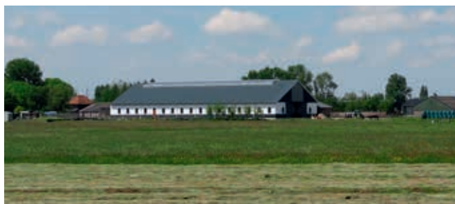
De kleur van deze stal sluit niet aan bij de kleuren van het landschap. Door kleuren te kiezen die passen in het landschap, ontstaan eenheid en rust.
