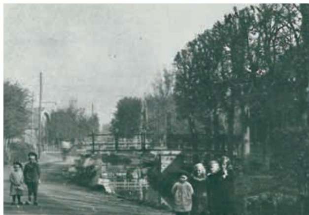
Kenmerkende veenweide erven met een bomenrij dicht rond de boerderij en ontsloten door bruggetjes, rond het jaar 1900.
