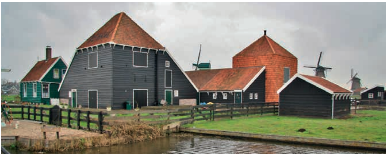
Een onvolledige stolp en dakpankapberg (Zaanse Schans).
