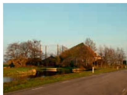
Het voorerf heeft een karakteristieke, groene aanblik. De bijgebouwen staan achter de achtergevel van de stolpboerderij of woning.
