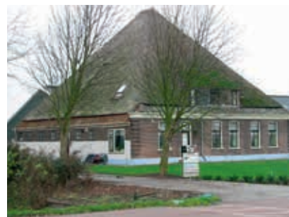
De Noord-Hollandse normaalstolp.
