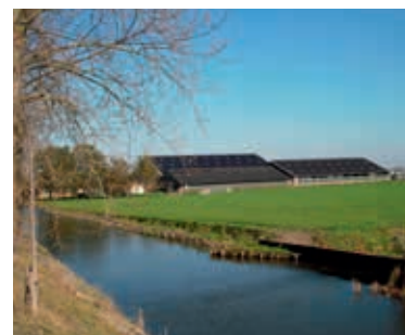
Voor grote agrarische bedrijfsgebouwen gelden speciale criteria: Het gebouw moet qua uitstraling passen bij de bestaande gebouwen op het erf en bij de erfinrichting.
