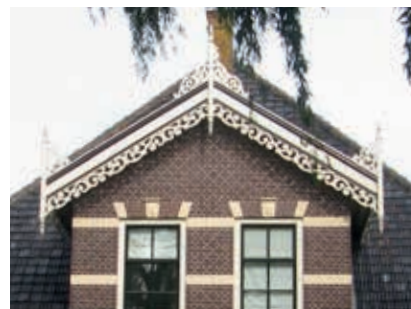
Lofwerk aan de topgevel.
