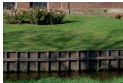
Voorkom het gebruik van hoge houten beschoeiingen. Een te hoge beschoeiing is vaak nogal nadrukkelijk aanwezig. Houd de beschoeiing dan onder of op de waterlijn.
