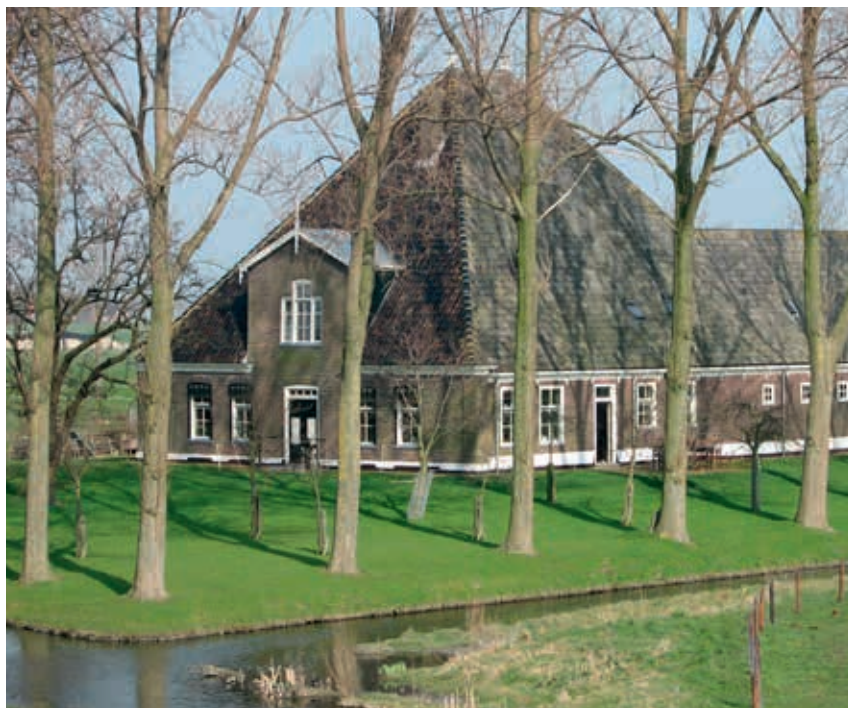
Authentieke stolpboerderij met staart (uitbouw stal achter) en karakteristieke bomenrij op de erfanden langs de sloot. De stolp is zichtbaar tussen de bomen door.
