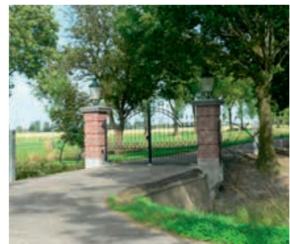
Sierlijk ijzeren poorthek. Kenmerkend zijn de stenen of stalen kolommen met een hek aan de kant van het erf of midden op de brug, maar nooit aan de wegkant.
