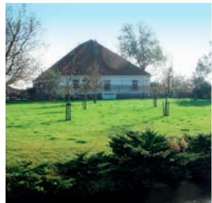
Regel van de gemeente is dat nieuwe stolpen op ongeveer één stolpbreedte van de wegsloot af staan. Ze mogen dus niet verder naar achteren worden gebouwd. Deze stolp staat te ver.
