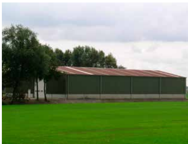
Regel van de gemeente is dat nieuwe gebouwen op een minimale afstand van de erfgrans (insteek sloot) gebouwd worden. Op de erfrand komt inheemse beplanting.
