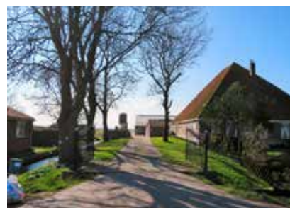
Op veel erven is het doorzicht over het erfpad verdwenen door bouw van nieuwe gebouwen.
