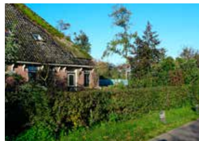
De dichte beplanting die stond op het voorerf is verwijderd zodat de mooie gevel van de stolpboerderij weer zichtbaar is.
