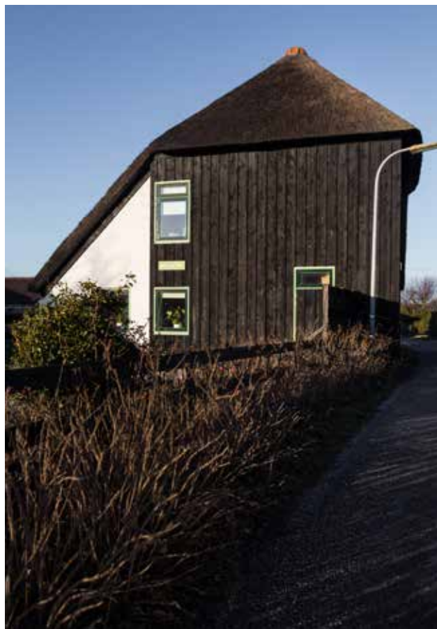
Karakteristieke kapschuur in Camperduin.
